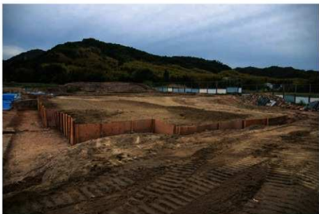
(3)埋め戻し後状況(北西から)
