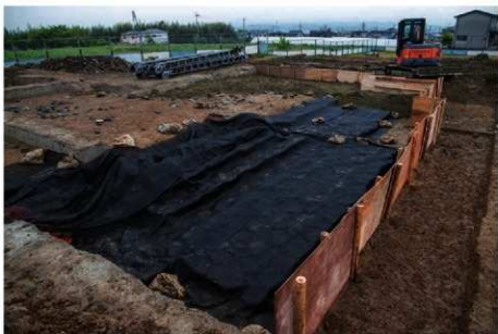
(1)遺構養生及び埋め戻し状況 (北東から)
