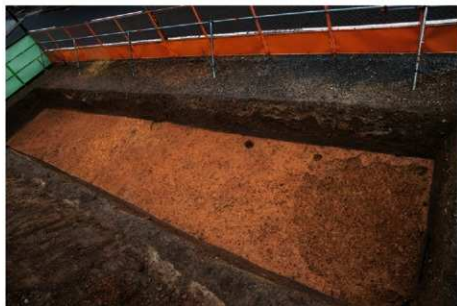
(1) 6トレンチ西半全景 (北東から)
