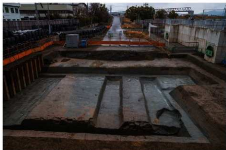
(2) B地区第1面全景(南から)
