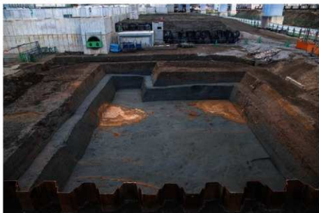
(2) B地区第2面全景(西から)
