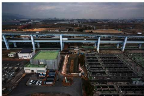
(3) C 1 地区第 2 面遠景(南から)
