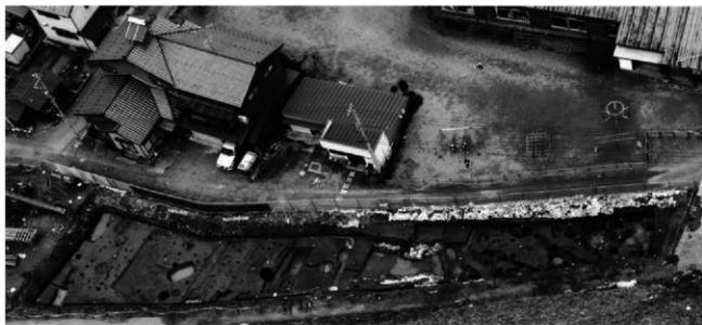
(3) I区-④全景(南より)
