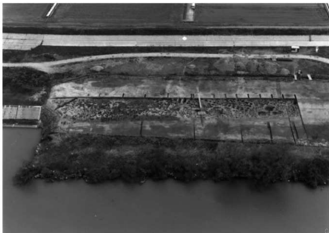
(1) I区遠景 (西から)
