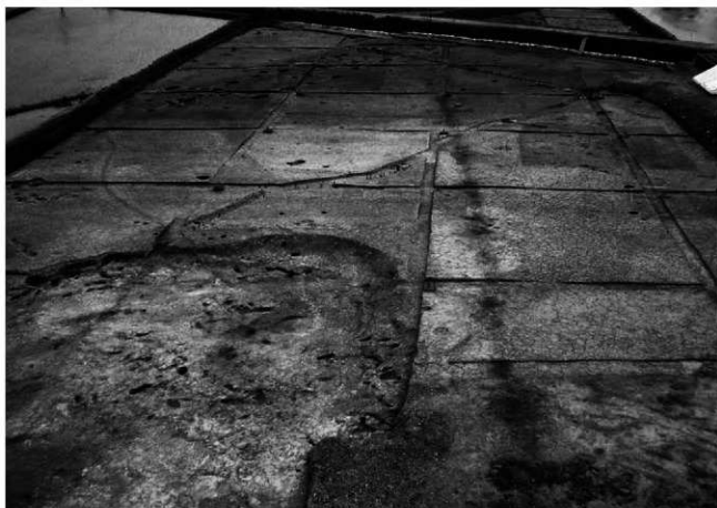
(2) H19・20㉑区全景 (北西より)
