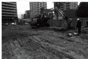
A 事業地近景 (北西から)
