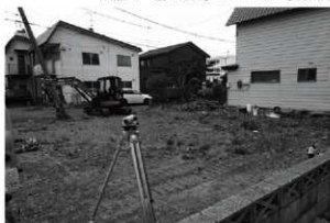
A 事業地近景 (北から)
