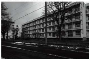
B 事業地近景 (南東から)
