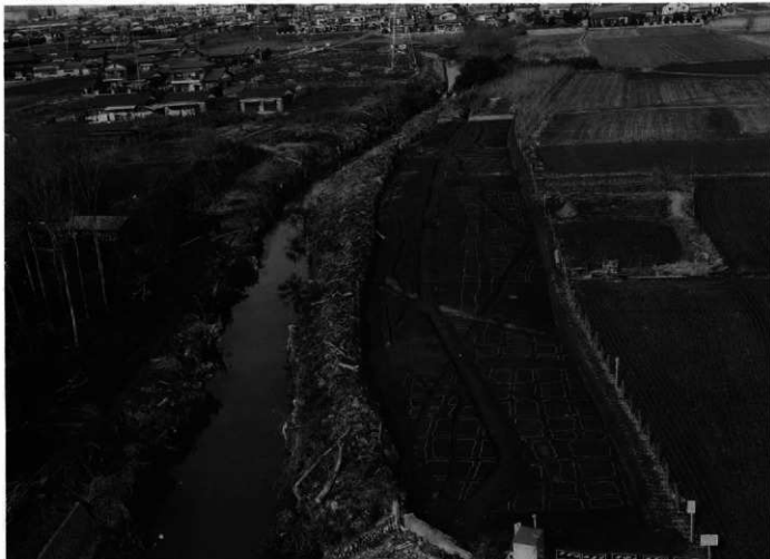
1.Hr-FA下水田全景(南から)
