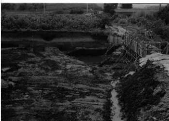
4.第Ⅲ河道と善勝寺堰取水路(北から)
