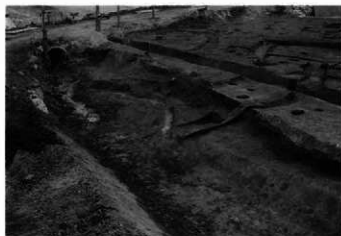
7.95号溝全景(南西から)
