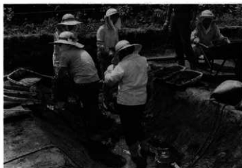
3. 作業風景(北西から)
