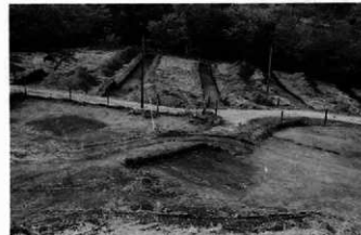
7. 5区試掘トレンチ調査
