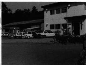
7 上越線調査事務所近景
