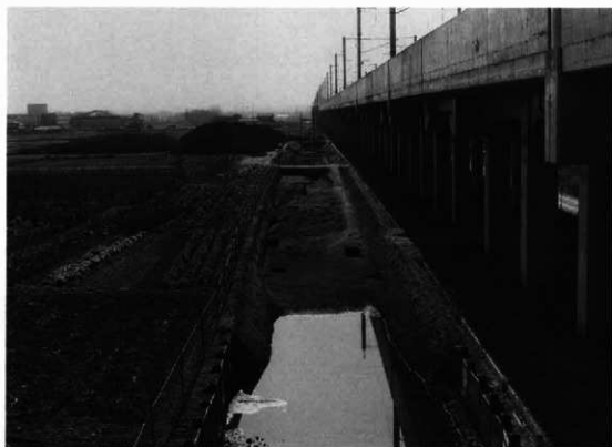
第686図 5-6区東側道(北から)
