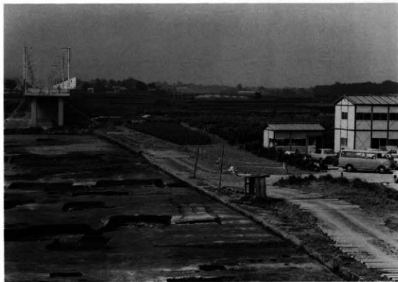
5区東側全景（南から）
