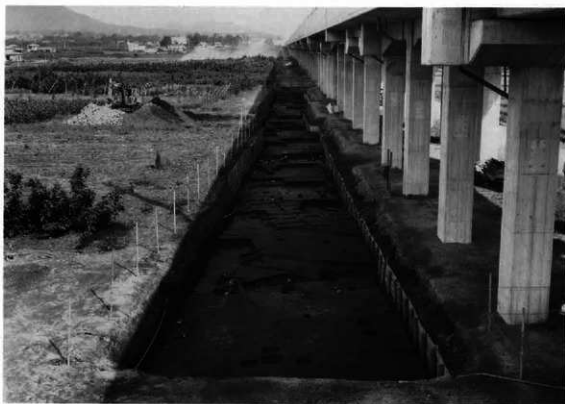
2区全景（西側道，南から）
