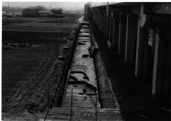
2区全景（東側道，北から）
