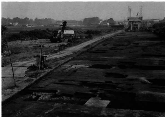
5区東側全景（北から）
