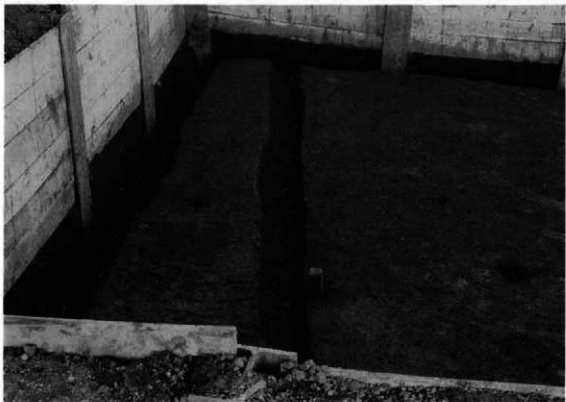
3区15号溝（東側道，西から）
