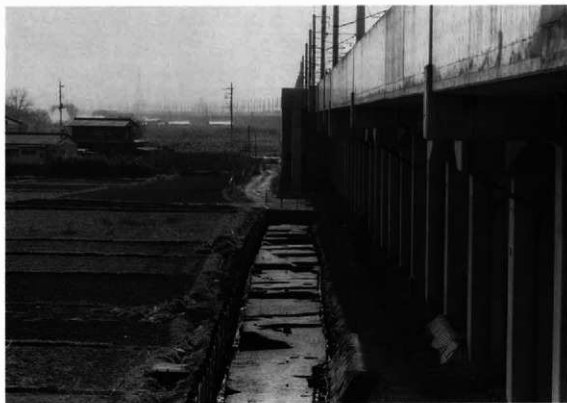
2区南側全景（東側道，北から）
