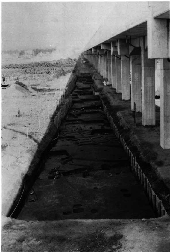
2区全景（西側道，南から）
