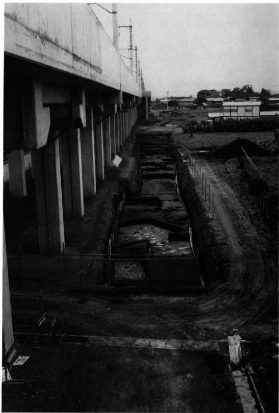
2区全景（西側道、北から）
