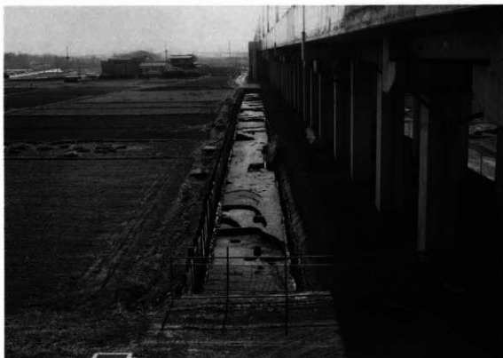
2区掘形全景（東側道，北から）
