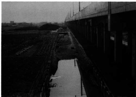
5・6区全景（東側道，北から）
