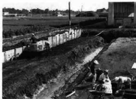
▲3区東壁の土止め工事（北西から）
