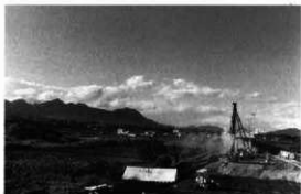
▲6区-5区タイ打ち（南から）
