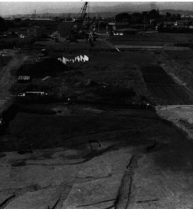
三ツ寺II遺跡から南を望む 手前は三ツ寺II遺跡1区B観石下水田、奥のクレーンのあるところは三ツ寺I遺跡で安全対策工事中。
