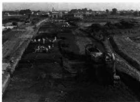
▲5区奈良・平安時代面の掘削と遺構確認（北から） 住居の重複は4区よりも少ない。左手は未着手の東側道。
