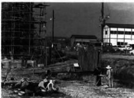
▲5区 工事迫るなかでの調査（南から）
