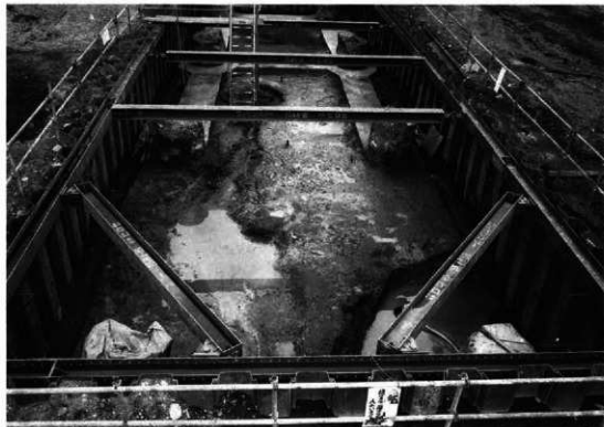
5-9図 1区1号井戸完掘状況(南から)
