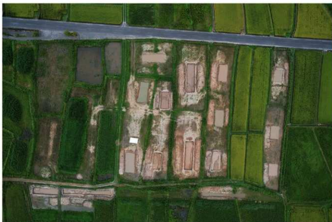
(2) 小規模調査C・E・F地区全景(上が北)
