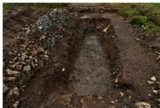
(1)D1トレンチ全景(東から)
