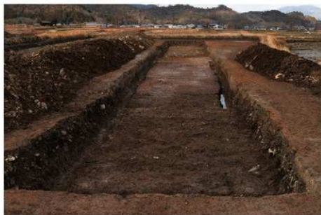
(1) B1トレンチ全景(南から)
