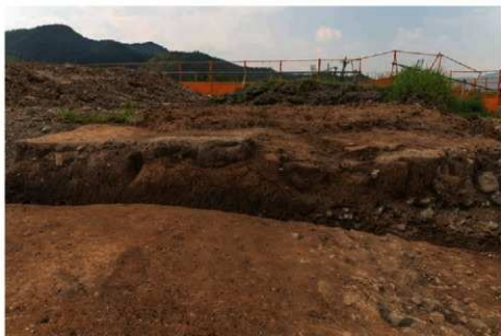
(1)B地区本調査区北壁中央部 断面(南から)
