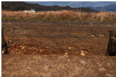
(3) B1トレンチ北壁断面(南から)
