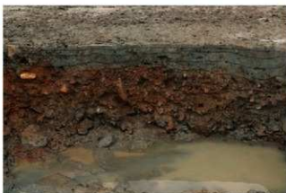
(6) B4トレンチ北壁断面(南から)
