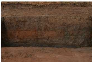
(8) B10トレンチ北壁断面(南から)
