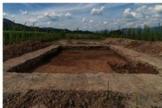
(3) F11トレンチ全景(南から)
