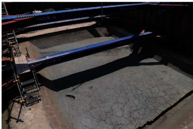
(2) F21区中世面完掘状況(北東から)
