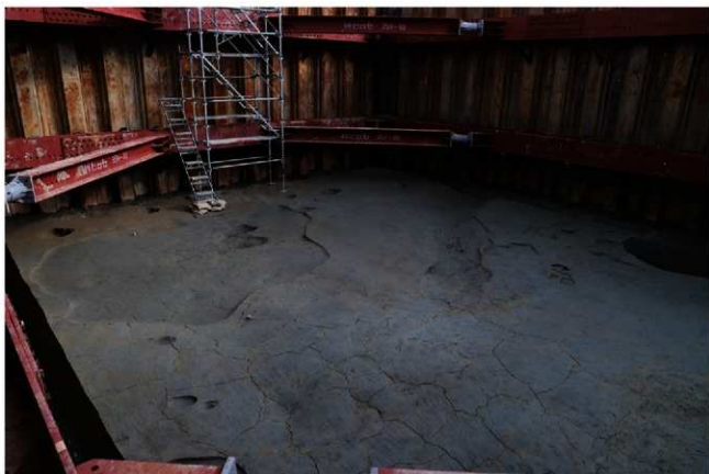
(2) F17区中世面完掘状況(北西から)
