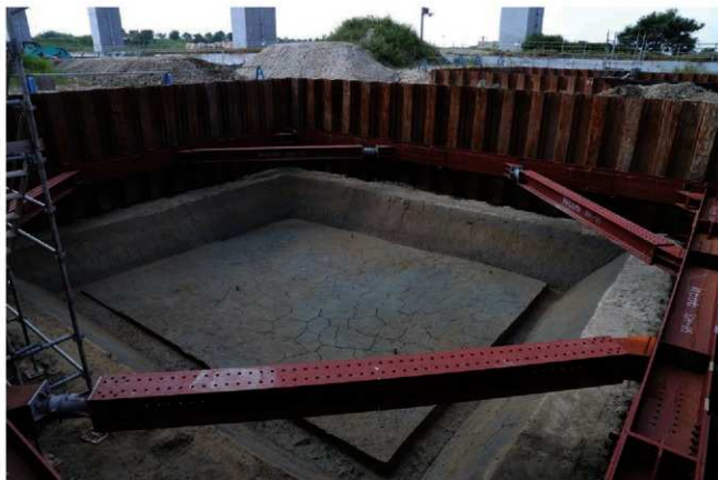
(2) F16区完掘状況(南東から)
