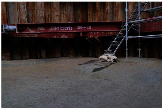
(2) F17区基盤層面島畑113(南西から)
