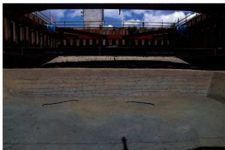
(2) F21区北壁土層断面(南から)
