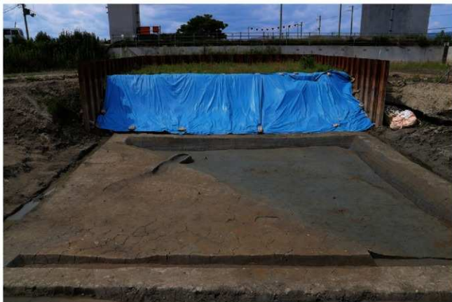
(1) F19区完掘状況(南から)
