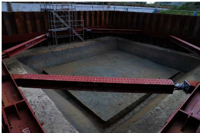
(1) F16区完掘状況(北東から)
