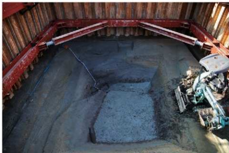
(1) F18区下層調査完掘状況 (北から)
