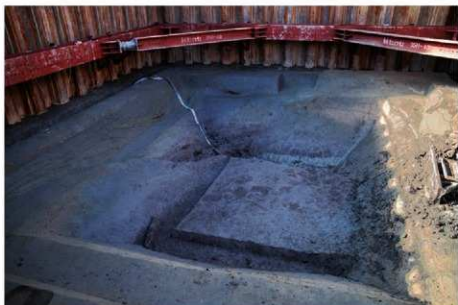
(2) F18区下層調査有機物層面の 検出状況(北から)
