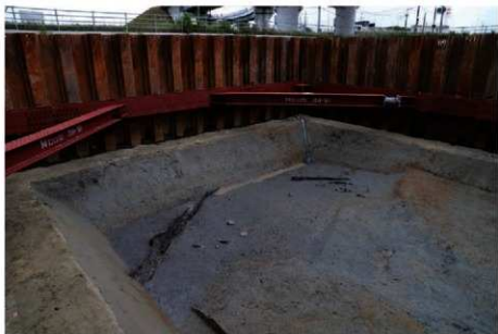
(1) F15区 S D1502遺物出土状況 (北西から)
