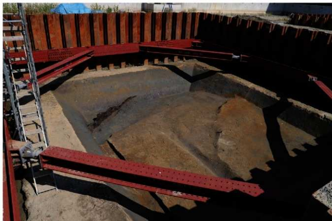
(1) F15区完掘状況(北西から)
