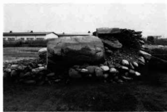
6 奥壁石設置のための下部補強
