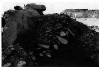
5 奥壁背後の裏込め状態
