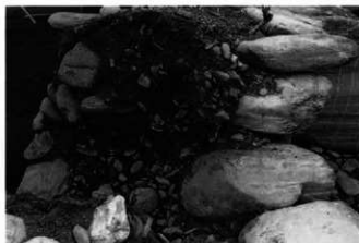
2 玄室左壁裏込め状態
