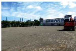
D 事業地近景 (南西から)
