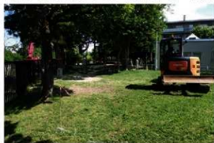
A 事業地近景 (南から)
