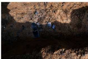
F 竪穴住居跡遺物発見状況 (2) (北西から)
