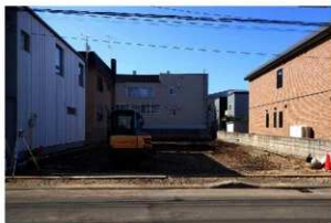
E 事業地近景 (北西から)
