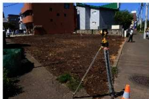
A 事業地近景 (北東から)
