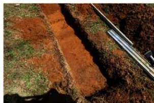
C TT90-65 竪穴住居跡発見状況 (南西から)
