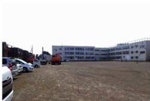
E 事業地近景 (北西から)
