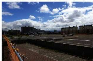
A 事業地近景 (南西から)
