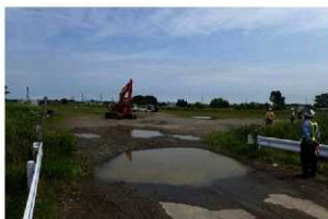
E 事業地近景 (南西から)
