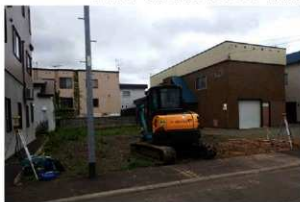
A 事業地近景 (北から)
