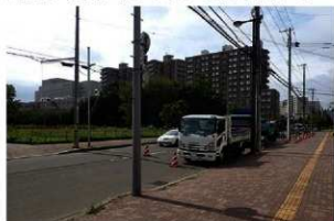
A 事業地近景 (北西から)
