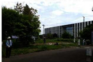
A 事業地近景 (南西から)
