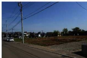
A 事業地近景 (南西から)
