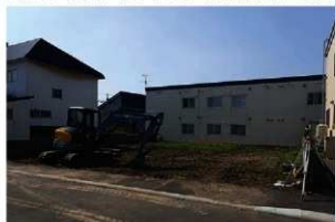
A 事業地近景 (北西から)
