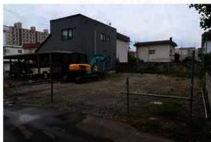
A 事業地近景 (北西から)
