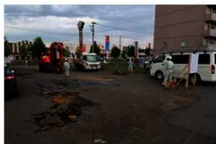
E 事業地近景 (南西から)
