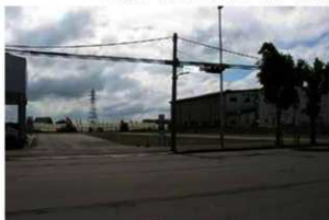
A 事業地近景 (北西から)
