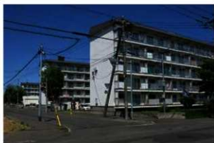
D 整理番号 17-3-301 事業地近景（南西から）
