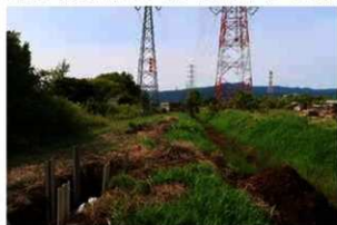
A 事業地近景 (北東から)
