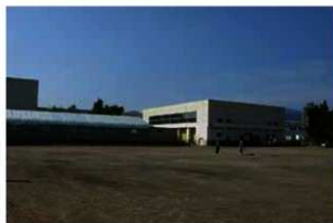
A 事業地近景 (北から)
