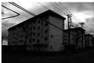
A 整理番号15-3-321 事業地近景（西から）
