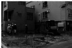
A 事業地近景（北から）
