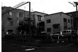
E 事業地近景 (南西から)
