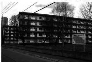
B 整理番号15-3-321 事業地近景（南から）
