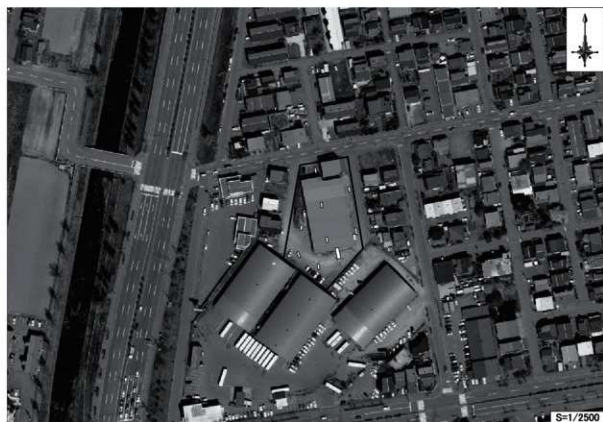
整理番号14 2 312試掘調査実施箇所
