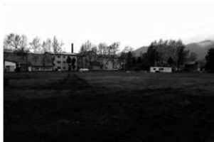
G 整理番号14-3-320 事業地近景(北東から)
