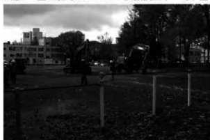
A 事業地近景(北から)
