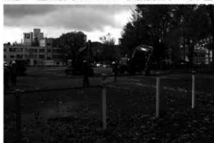
A 事業地近景(北から)
