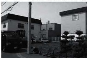
A 事業地近景(北東から)
