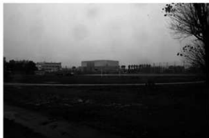
A 事業地近景(北東から)
