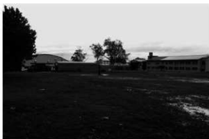
H 整理番号12-3-322 事業地近景(南西から)
