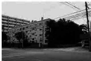
E 事業地近景(北西から)
