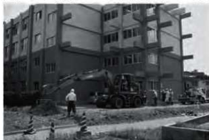
A 事業地近景(西から)
