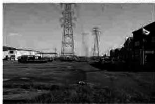
A 事業地近景(南西から)
