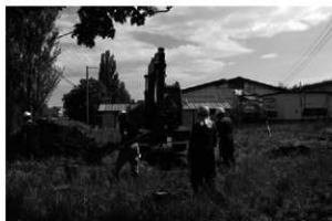
G 調査状況(北から)
