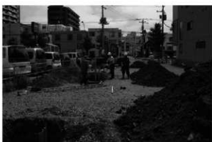
H 調査状況(北東から)
