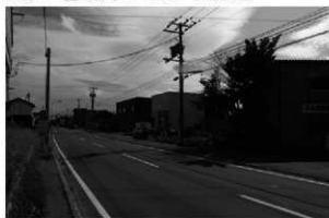
A 事業地近景(北から)
