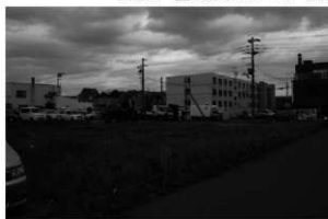
A 事業地近景(南西から)
