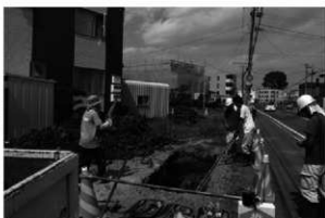
H 調査状況(南東から)
