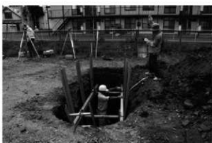
H 調査状況(南東から)
