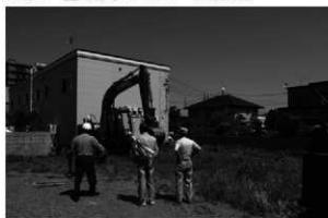
A 事業地近景(南から)
