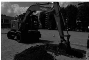
H 調査状況(南東から)
