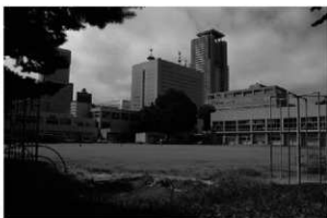
B 事業地近景(北東から)
