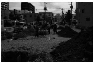
H 調査状況(北東から)
