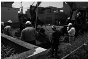
H 調査状況(北から)
