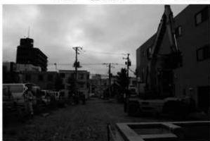
B 事業地近景(北東から)
