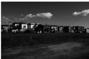
H 整理番号10-2-311 事業地近景(西から)
