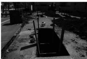
H 調査状況(西から)
