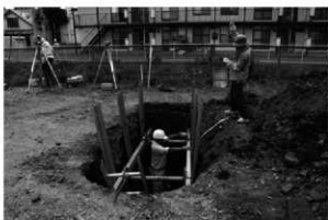
H 調査状況(南東から)
