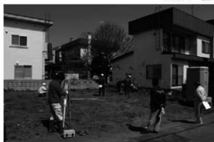
A 事業地近景(南から)
