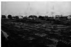
D 整理番号09-2-313 事業地近景(西から)
