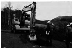
G 調査状況(南西から)
