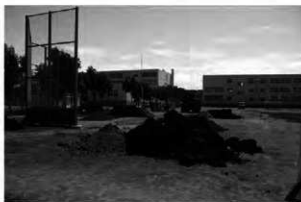
H 調査状況(北西から)
