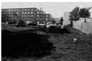
H 調査状況(北から)
