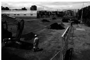
G 調査状況(東から)
