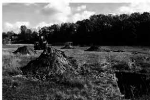
A 事業地近景(南西から)
