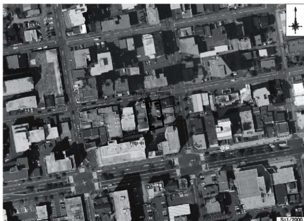
第55図 整理番号09-2-321 試掘調査実施箇所
