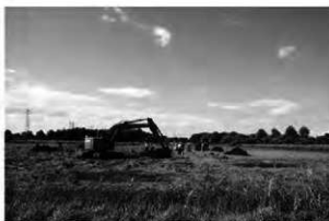
H 調査状況(北東から)
