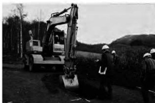
G 調査状況(南西から)
