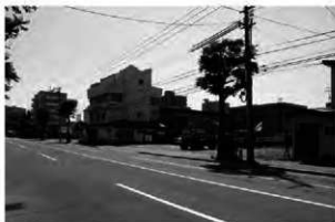
A 事業地近景(北西から)
