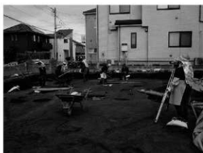
実測作業状況 (2)
