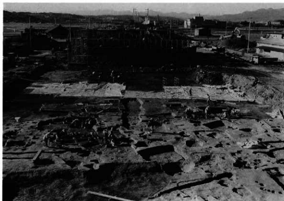
71km250~290m付近 調査風景 (東から)
