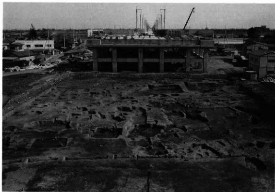
田端地区B区 71km250m 付近(1) (西から)
