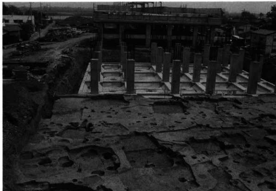
田端地区B区 71km285m 付近北側(1) (西から)
