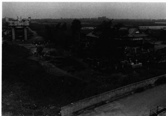
第11図 寺東地区第3次調査 南側道1号溝東辺の調査風景
