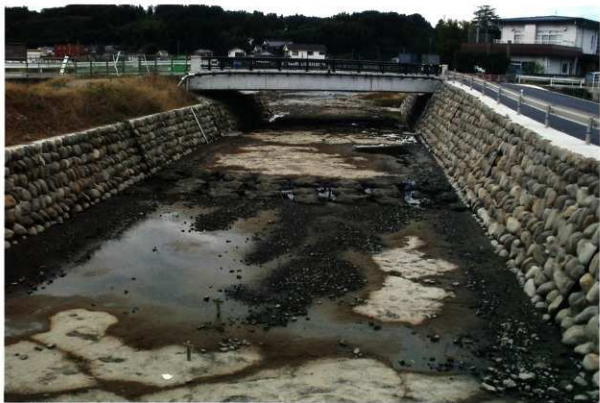
調査区工事完成後現況(北東から)
