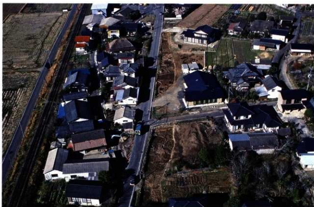
調査区全景 (上) 北より (下) 南より
