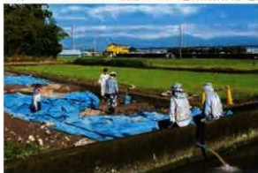
排水作業(Ⅱ区)
