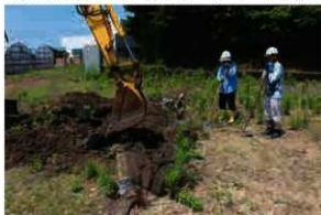
コンクリート畦畔除去(1区)
