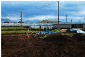
排水作業(Ⅱ区)
