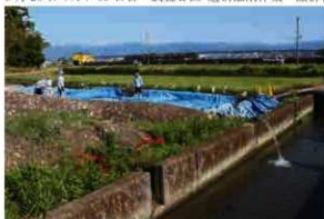
排水作業(Ⅱ区)
