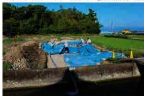
排水作業(Ⅱ区)
