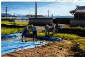
排水作業(Ⅱ区)
