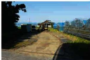
仮設駐車場敷設作業
