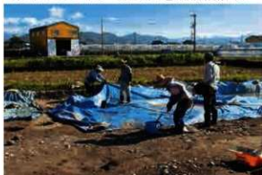
排水作業(Ⅱ区)
