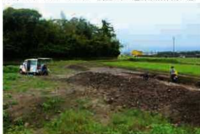
SX 1 礎群測量作業：下位部
