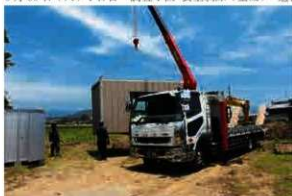
コンテナハウス搬入
