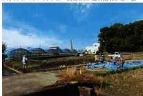
排水作業(Ⅱ区)
