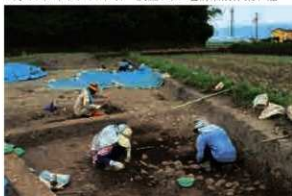
遺構掘削作業(Ⅱ区)
