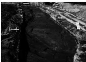
1～3号溝完掘状況 (東から)
