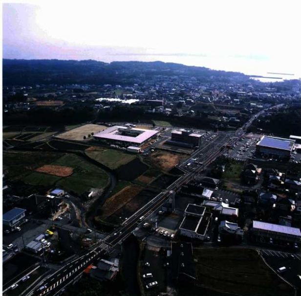
国道10号別大拡幅（藤原地区）全景
