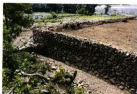
石垣E内面(南から)
