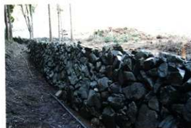
B区シシ垣外側(南から)
