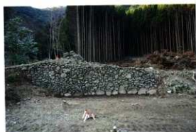
A区シシ垣外側(東側)
