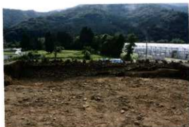
石垣D-1内面南半(東から)
