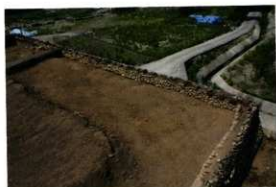
石垣D-1内面南半(東から)
