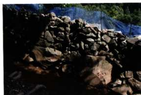
石垣A外面部分(北から)
