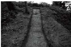
2. 1トレンチ第2段斜面断割り状況 (東から)
