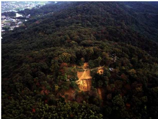
3. 大日山 35号墳 全景 (西から)
