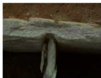
仕切石の加工
