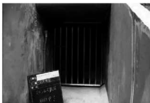
ステンレス扉取付完了
