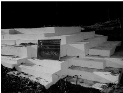
墳丘内 EPS 使用状況 (前山 A 114号墳)
