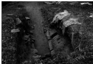
本体工事着手前
