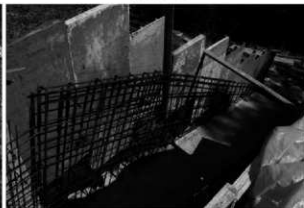
保護覆屋側面鉄筋組立
