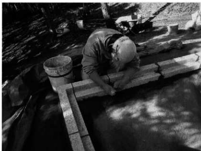
花崗岩基礎据え付け状況
