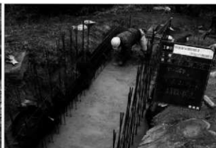
ベースコンクリート打設状況
