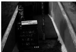
石室入口保護施設三土舗装
