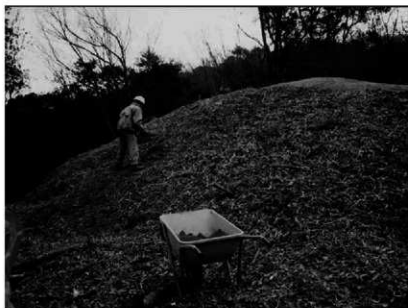
真砂土の人力運搬と墳丘盛土
