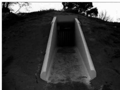
本体工事完了状況
