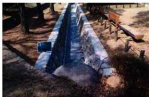
1号排水路 (No.5+9.0) 完成
