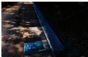
13号排水路 完成
