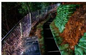
6号排水路(No.2 ~ No.3) 完成
