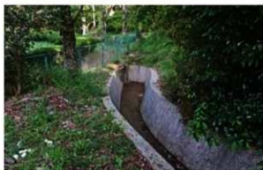
3号a排水路(B.P) 完成
