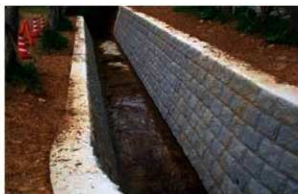
1号排水路(B.P) 完成
