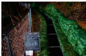
6号排水路(No.4 ~ No.5) 完成
