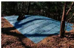
前山B153号墳 植生ネット敷設 (完了)
