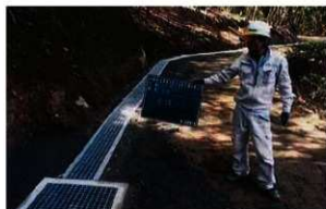
15号排水路 完成
