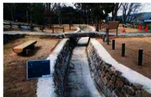
1号排水路 (No.7) 完成
