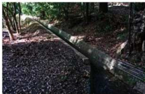
3号b排水路(E.P ~ No.1) 完成
