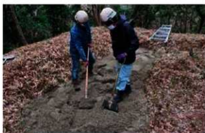
前山B42号墳 石室の埋戻し状況
