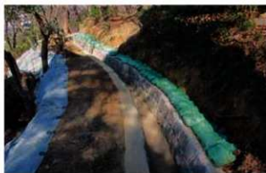
3-2号排水路(No.11) 完成
