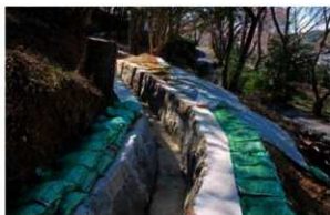
3-2号排水路(No.2) 完成
