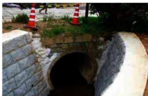
1号排水路(No.1+0.5) 完成
