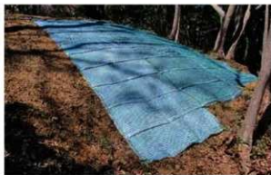
前山B162号墳 植生ネット敷設 (完了)
