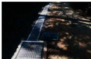
13号排水路 完成
