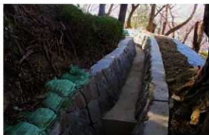
3-2号排水路(No.5) 完成
