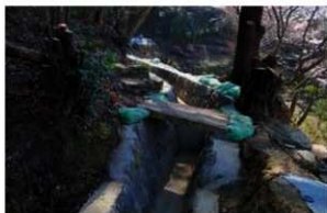
3-2号排水路(No.9) 完成
