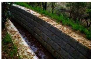
3号b排水路(No.1 ~ No.2) 完成
