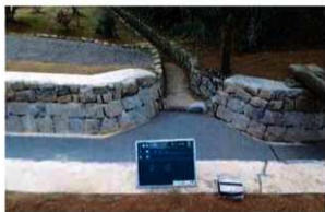
1号排水路(No.2+12.4) 完成
