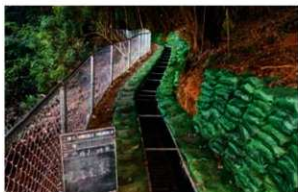
6号排水路(No.3 ~ No.4) 完成
