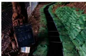
6号排水路(No.5 ~ E.P) 完成
