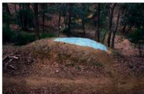
前山B150号墳・植生ネット敷設 (完了)
