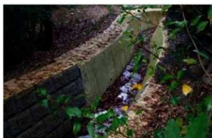
3号a排水路(E.P) 完成
