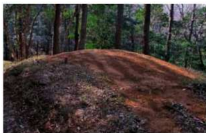
前山B152号墳 石室埋戻し・真砂土による墳丘盛土
