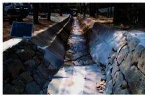
1号排水路 (No.8+14.3) 完成
