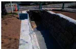
1号排水路(No.1+5.5) 完成
