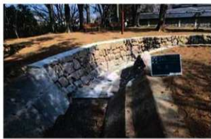
1号排水路 (No.8+14.3) 完成
