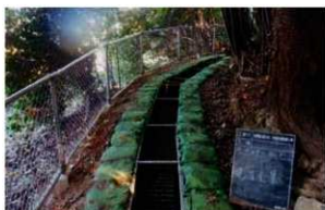
6号排水路(B.P ~ No.1) 完成
