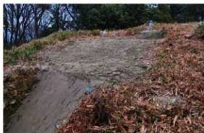
同 石室の埋め戻し完了
