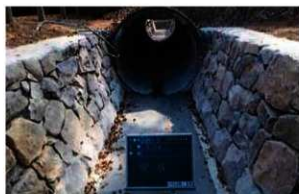
1号排水路 (No.5+9.0) 完成
