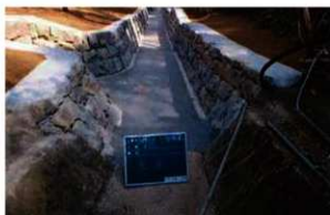
1号排水路 (No.4+6.6) 完成
