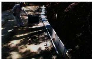
15号排水路 完成
