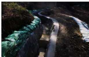
3-2号排水路(No.3) 完成
