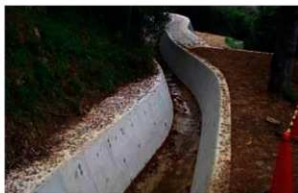
3号a排水路(B.P ~ No.1) 完成
