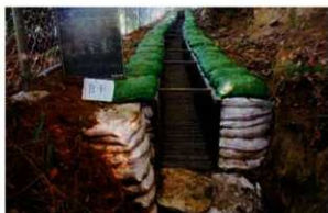
6号排水路(B.P) 完成
