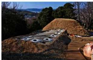
レプリカ設置用基礎工事
