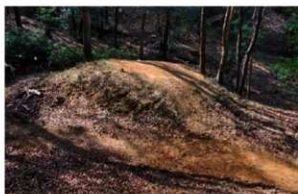
前山B150号墳 石室埋戻し・真砂土による墳丘盛土
