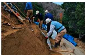
同 墳丘盛土状況（後円部）
