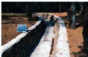
1号排水路 (No.8) 完成
