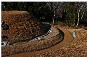
レプリカ設置用基礎工事
