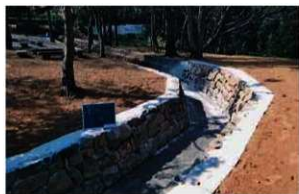
1号排水路 (No.8) 完成
