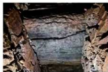
玄室前道天井石の割れ
