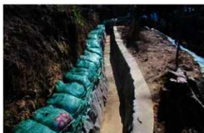
3-2号排水路(No.6) 完成
