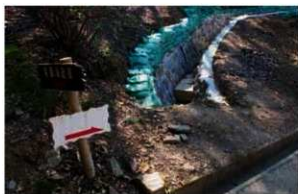
3-2号排水路(No.BP+9.0) 完成
