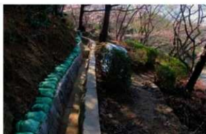
3-2号排水路(No.8) 完成
