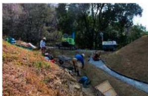
同 後円部テラス碎石敷設状況
