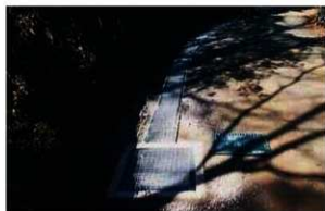
10号排水路 完成
