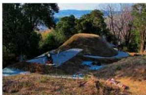
同 前方部上面碎石敷設状況
