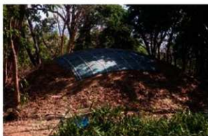
前山B42号墳・植生ネット敷設 (完了)
