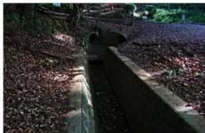
3号排水路(E.P) 完成
