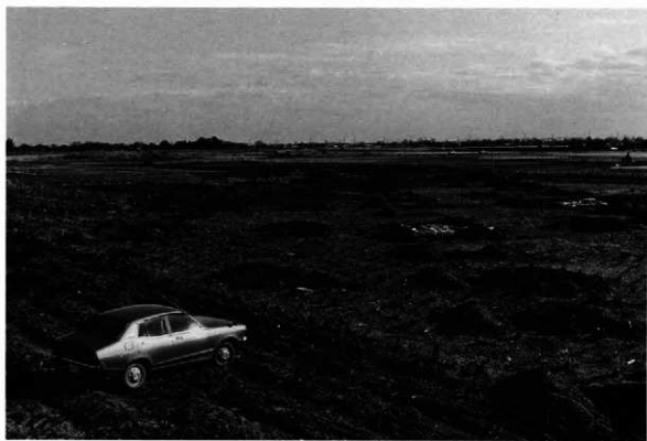
トレンチ掘削状況（南東方向を遠望）
