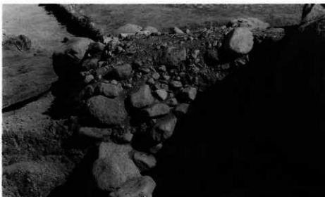
裏込め石の状態
