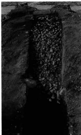
トレンチ掘り下げ状態
