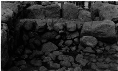
閉塞石の状態
