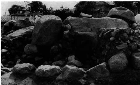
裏込め石の状態
