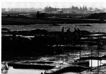
4. 小町田遺跡 排水作業
