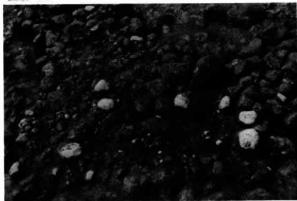
2号特殊井戸 石敷状態
