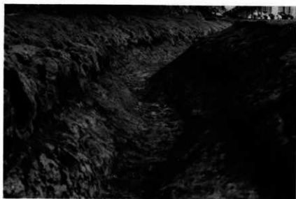
2号特殊井戸 溝部の状態(北 より)
