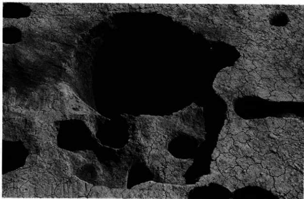
第3拉張区SE07近景 北→
